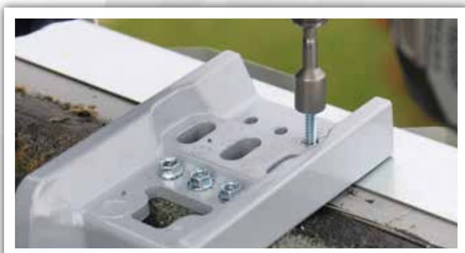
Fixation du sabot Z sur acrotère métallique
